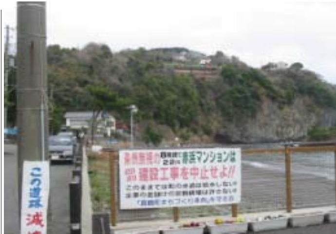
マンション建設に抗議する看板の先にあるのが問題の現場
