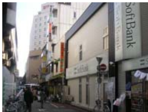
吉祥寺南口のバスターミナル予定地(右側) 左側は補修工事中の井の頭線
