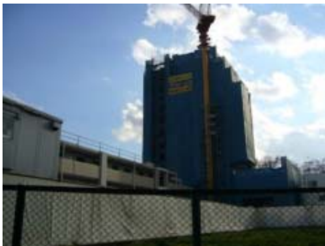
マンション建設現場
