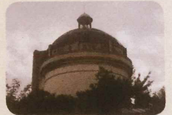
旧野方配水塔(中野区江古田)
